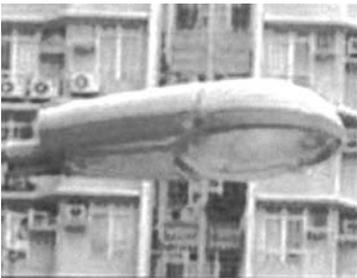
圖6-1：高壓壓鑄鋁道路照明燈
