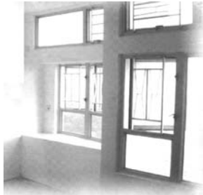
圖1-4: 新一代的 電力裝置齊全
