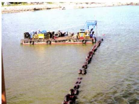
圖5-4: 鋪設海底電纜(1)
