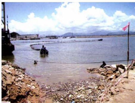
圖5-5: 鋪設海底電纜(2)
