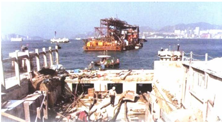
圖5-6: 鋪設海底電纜(3)
